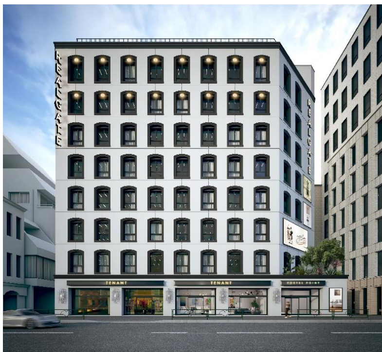
▲北原宿ビル外観（完成後イメージ）
